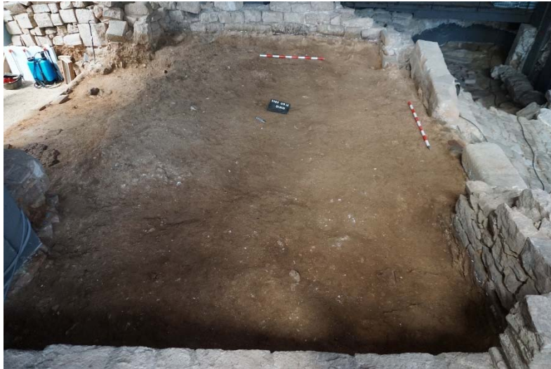
Fig.31 Vista general de l'estrat d'anivellament UE 30.938
