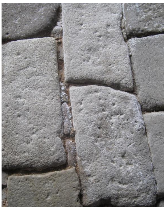
Detalls de la cristal·lització sobre els elements de paviments
