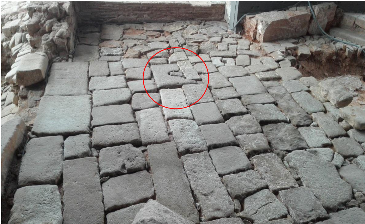
Imatge del paviment enllosat de l'entrada de la casa Santmartí- àmbit 22, amb la presència d'elements reaprofitats
