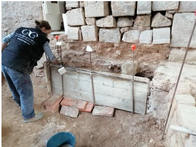
Procés d'encofrat i consolidació punt 158
