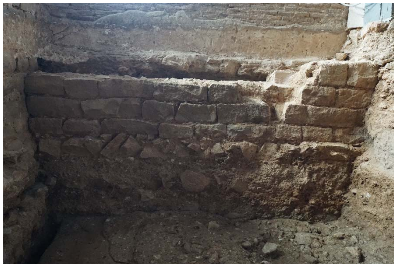
Fig.40 Vista general de la cara sud del mur UE 30.980 i la fonamentació UE 31.148
