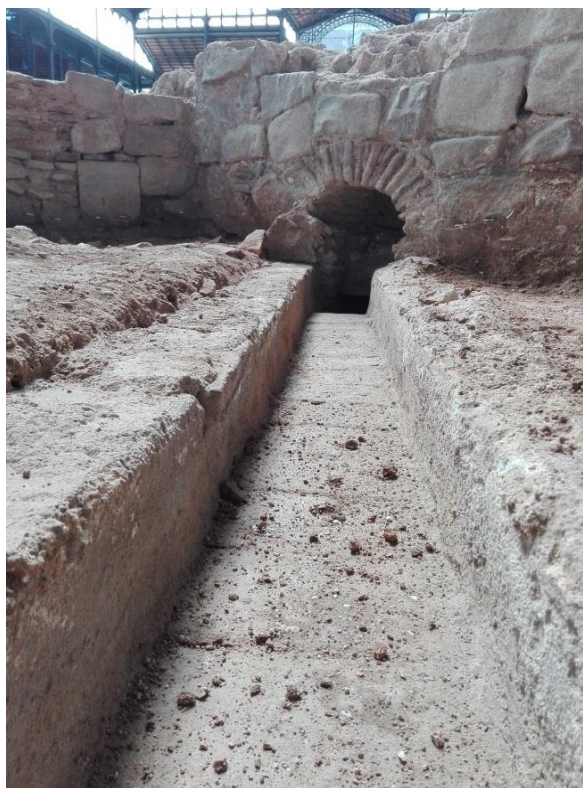
Imatge del canal des de l'interior de l'estança i visió del desguàs directe al Rec pròxim.
