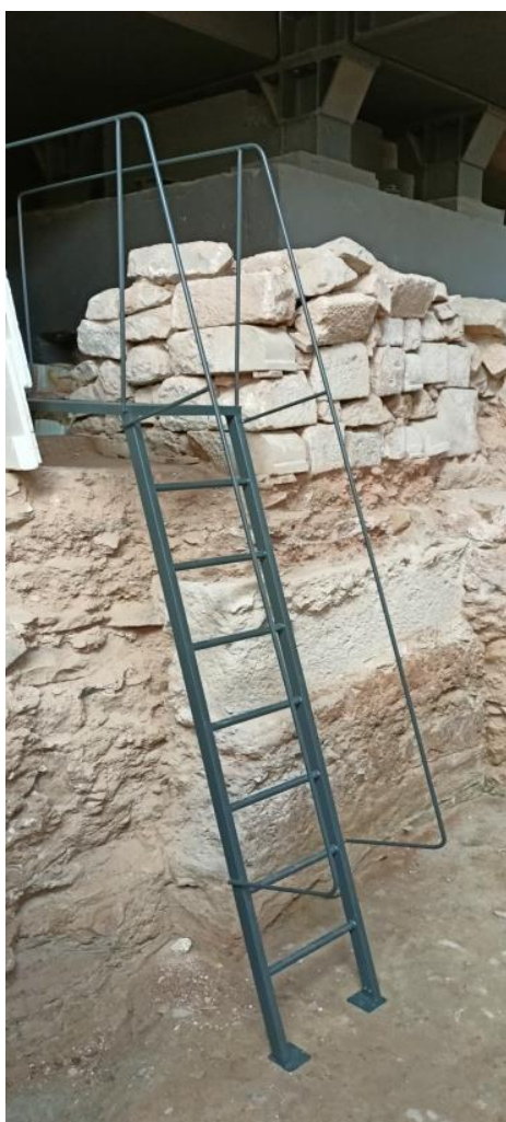
Detall de l'escala d'un sol tram i dels recolzaments al sòl.
