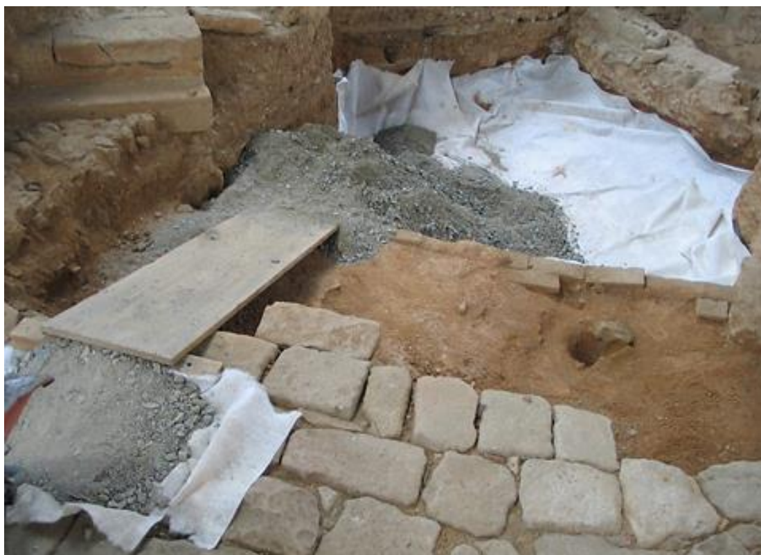
Procés de confinament amb grava, 2006
